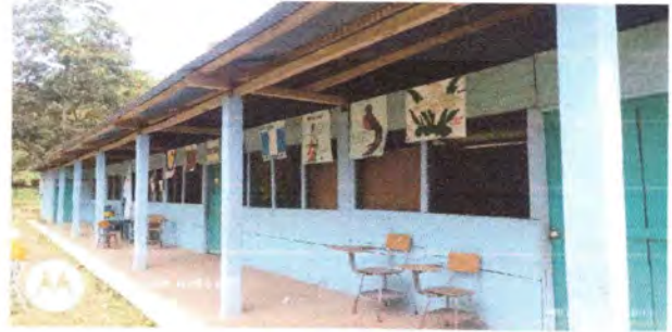
Foto 2: Sustitucion de bigas de madera a vigas de metal.
