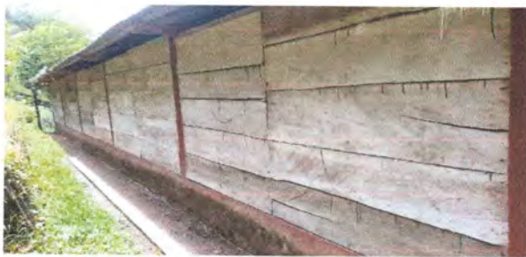
Foto 3: Pared de madera ya deteriorado. Se sustitua por hiladas de block y cimientos.
