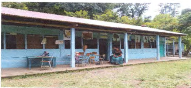
Foto 5: sustitucion de ventanales de madera a metal.
